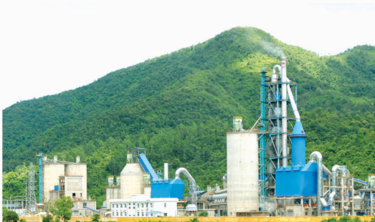
Dây chuyền sản xuất Xi măng công nghệ Lò quay, phương pháp khô đồng bộ khép kín tiên tiến và hiện đại nhất hiện nay.
